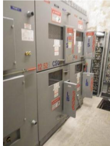
E01 – HV switch gear
